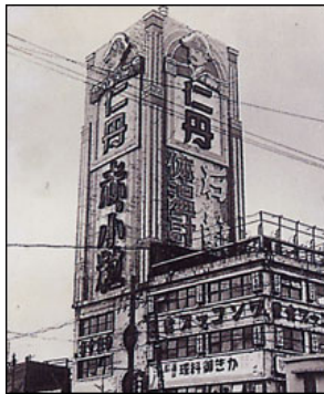
東京・浅草大広告塔 1932年(昭和7年)建設
